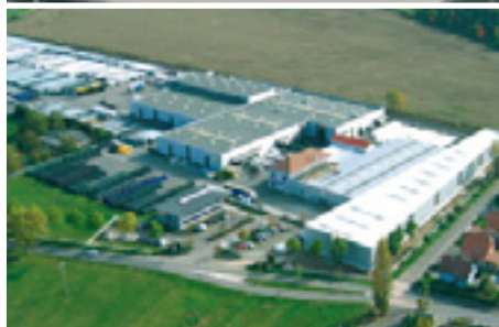
Site de production historique de Dachstein en Alsace
